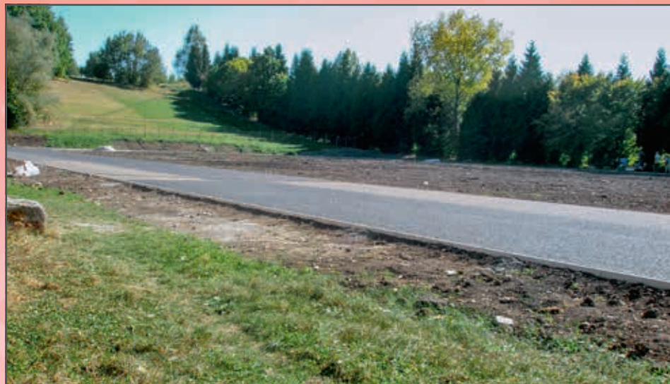
Snímky zachytávajú výstavbu útulného martinského 250-metrového oválu (z troch strán je zeleň, zo štvrtej telocvičňa) v športovom areáli na Východnej ulici na sídlisku Martin-Sever.
